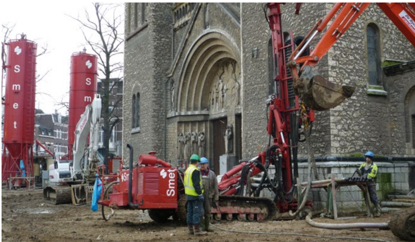
Herstel verzakking Lambertuskerk, Maastricht
