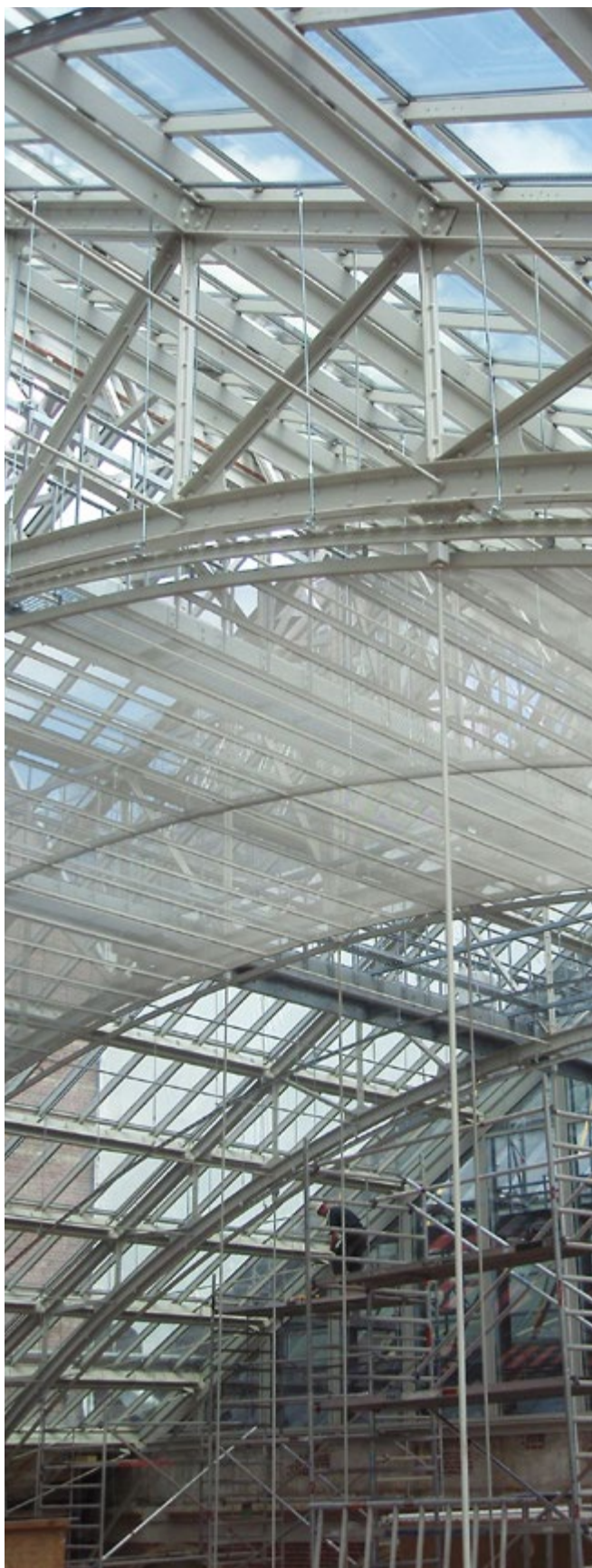
Vernieuwen dakconstructie Rijksmuseum, Amsterdam
