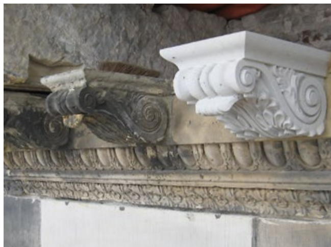
Vervangen consoles en demontage lijst, Paleis op de Dam, Amsterdam
