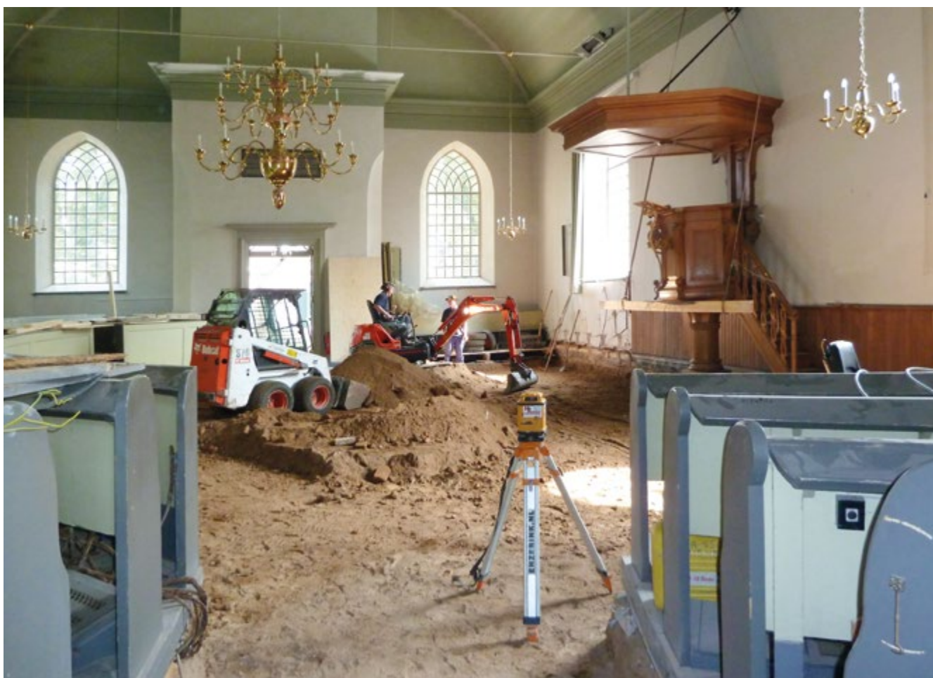
Vervangen kerkvloer Nederlands-hervormde kerk, Hummelo
